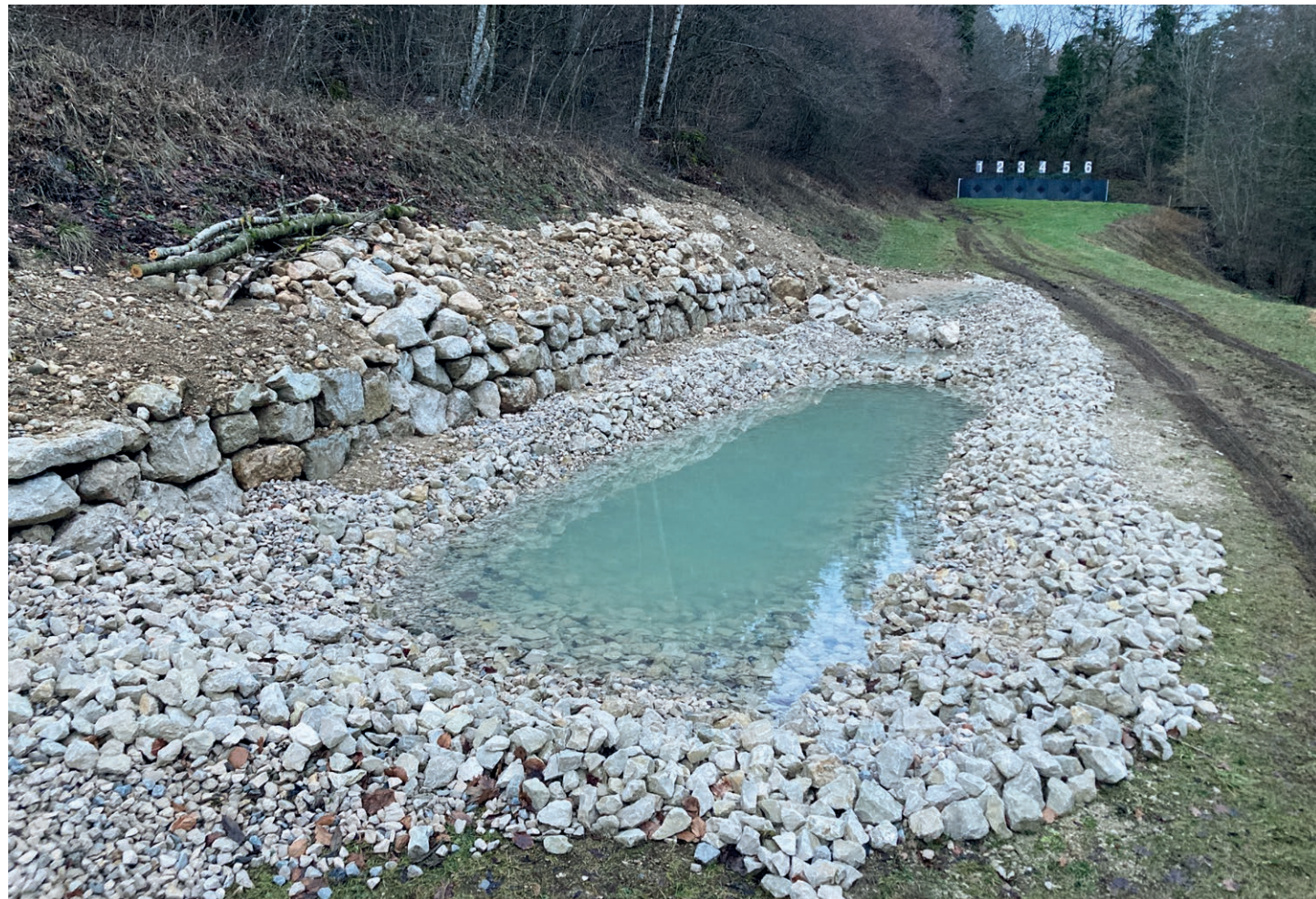
Nouvel étang fraîchement aménagé sur la ligne de tir du stand de Chézard, avec muret servant d'habitat terrestre pour l'alyte et favorisant également le lézard agile.
