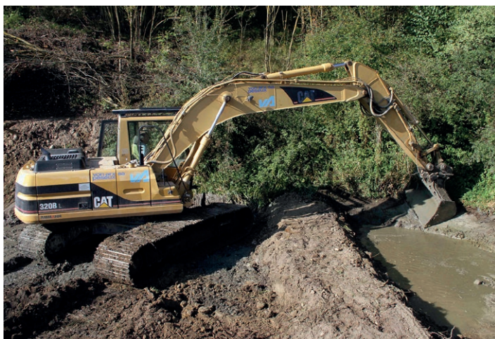
Entretien de l'étang des Sagnettes à Coffrane.
