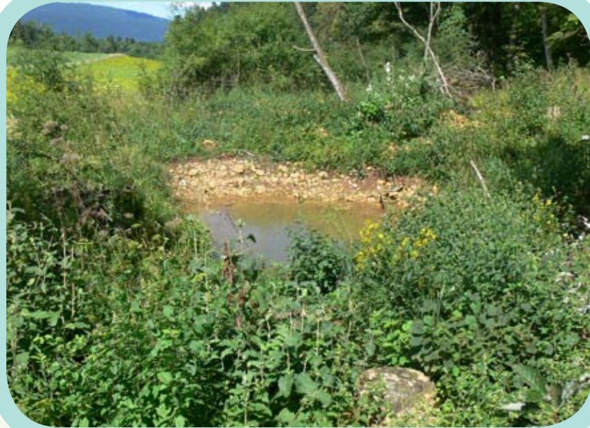
Aménagement d'un étang, Les Sagnettes, Coffrane. © Alain Lugon
