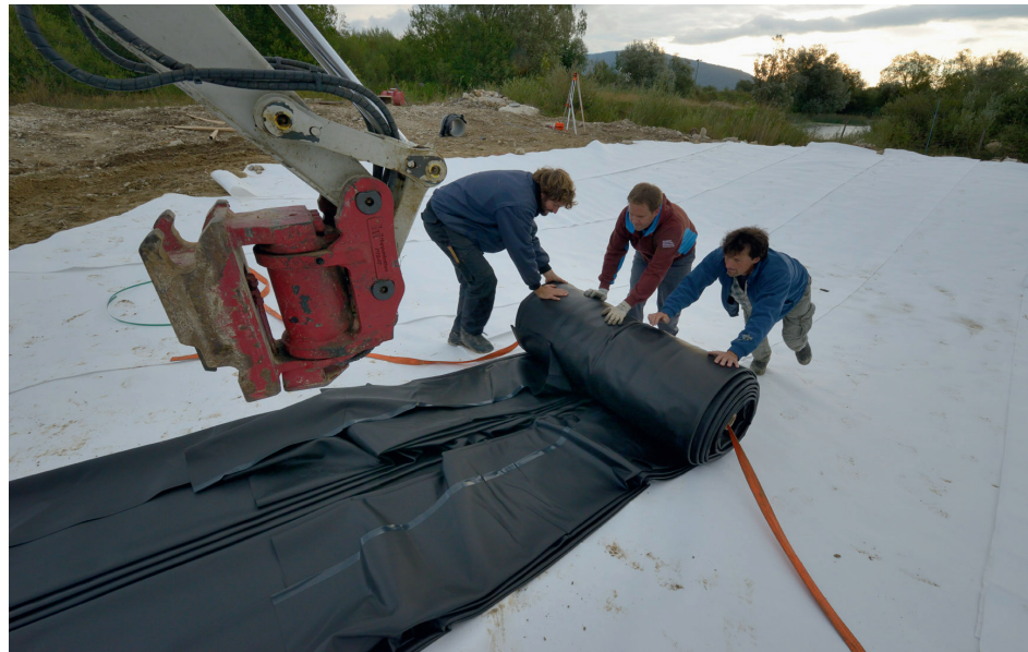
Mise en place de l'étanchéité caoutchouc
