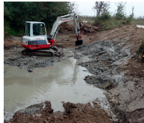
Finitions à l'aide d'une pelle-rétro de 6 t suite au curage réalisé depuis le bord avec une machine de 22 t
