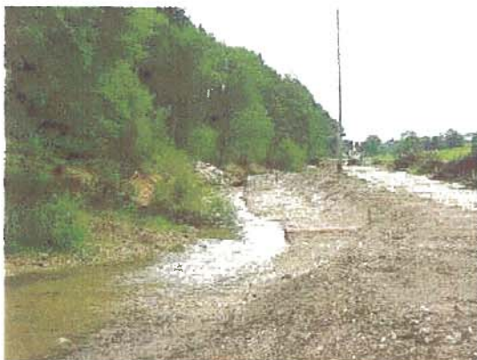
Peu après les travaux
