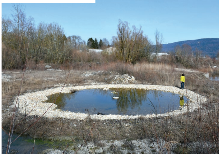
Étang vidangeable, étanchéifié avec un fond de béton maigre et une bâche, gravière de la Pôlière. © Alain Lugon
